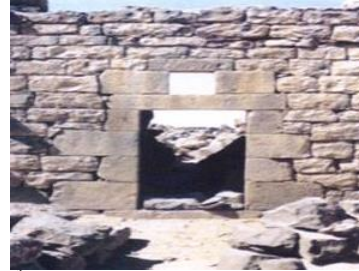
الصورة (7),(8): توضح طريقة تنفيذ الأبواب والنوافذ في قرية جابر السرحان.
