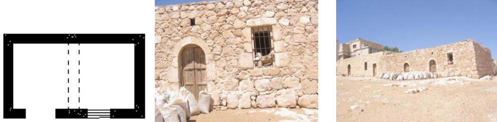
الصورة (21),(22): توضح طريقة تصميم بناء المسكن التقليدي في حيان المشرف
