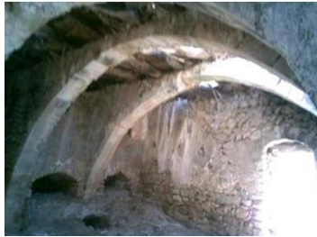
الصورة (3),(4): توضح طريقة تنفيذ الأسقف يستخدم الشبائح والعقود الحجرية في قرية جابر السرحان
